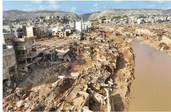
Hình 14. Nhà BTCT bị sập khi vỡ đập Derna, Libya năm 2023 [23]
