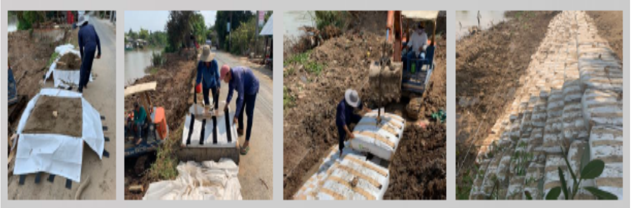
Hình 10. Thi công túi vải địa kỹ thuật
