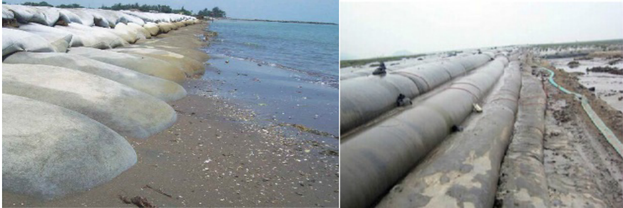
Hình 1. Bảo vệ bờ bằng túi, ống vải địa kỹ thuật [12]
