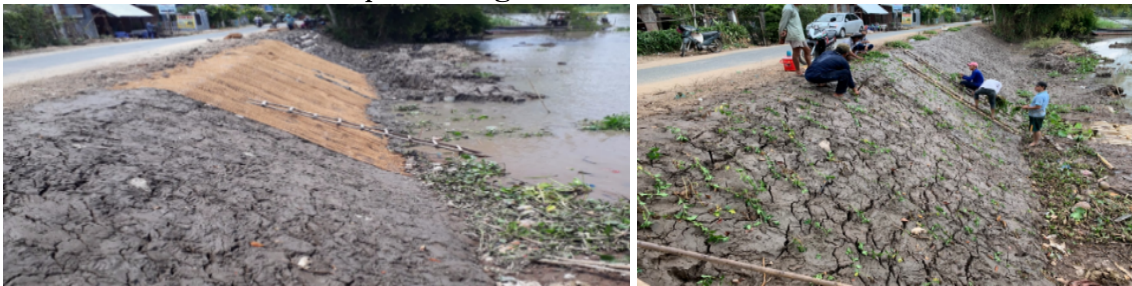
Hình 11. Thi công phủ lưới xơ dừa và trồng cỏ
