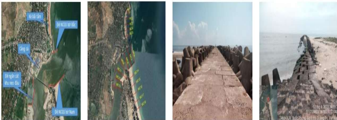
Hình 3. Vị trí công trình, MCN và hiện trạng đê ngăn cát, giảm sóng cửa Tùng
