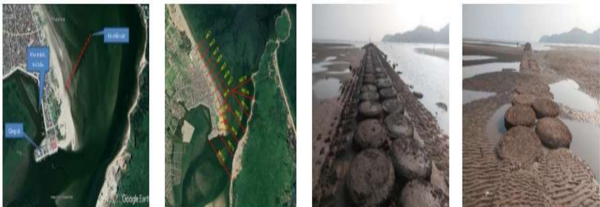
Hình 1. Vị trí công trình, MCN và hiện trạng đê ngăn cát, giảm sóng cửa Sốt
